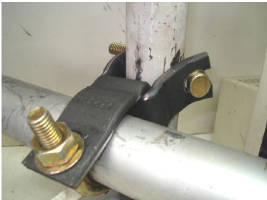
FOTO N.º 04 – CORPO DE PROVA APÓS A REALIZAÇÃO DO ENSAIO DE ESCORREGAMENTO EXCÊNTRICO
